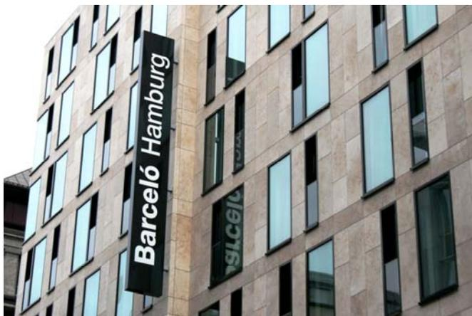
Konstruktion: scheibenstabilisierter Stahlbeton-Wand-Skelettbau mit umfangreichen Abfangungen im 1.UG, EG und 1.OG und 2-geschossiger Tiefgarage als WU-Konstruktion
